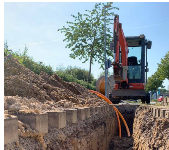
♥ Tiefbau in Stadtwerke-Qualität: 60 cm tief und mit großem Rohrdurchschnitt
